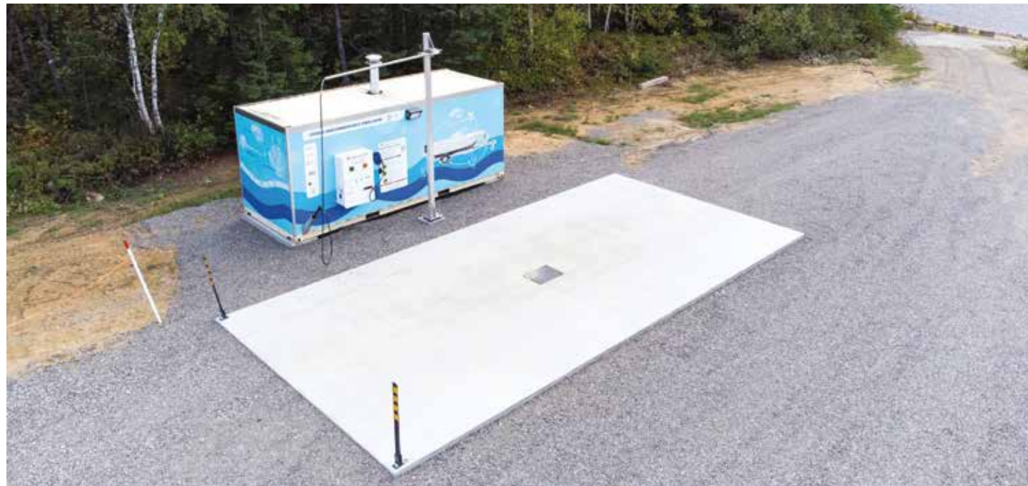
La station de lavage d'embarcation du lac à Jim à Saint-Thomas-Didyme. Celle-ci vise à protéger le lac à Jim lui-même, son émissaire la rivière Micosas qui se déverse dans la rivière Ouasiemsca et la rivière Mistassini dans laquelle se jette la Ouasiemsca à la hauteur de Girardville. Crédit photo : Fonds Rio Tinto Aluminium Canada.
