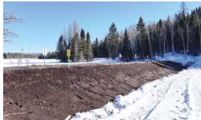
Digue filtrante terminée recouverte de terre végétale pour l'ensemencement de plantes herbacées indigènes.
