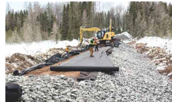
Digue filtrante en construction avec un cœur en tourbe et une carapace de toile géotextile filtrante recouverte de pierres.
