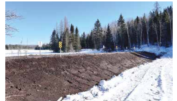
Digue filtrante terminée recouverte de terre végétale pour l'ensemencement de plantes herbacées indigènes.
